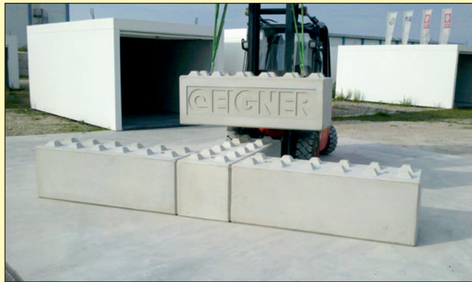
Versetzen von Betonblöcken
