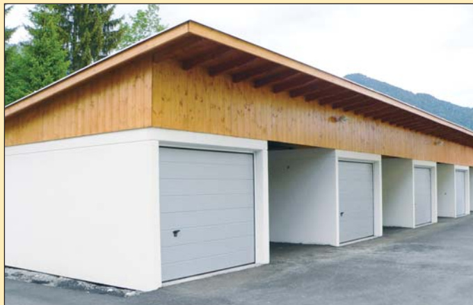
Garagenanlage mit Carport
