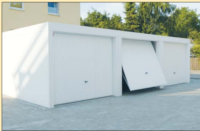
Reihengaragen mit Stahlschwingtoren
