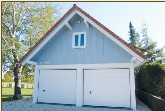
Doppelgarage mit Satteldach
